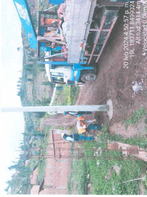
FOTO 35.- SUPERVISION, INSPECCIONANDO EL IZAJE DE POSTE. EN LA APV.QUEBRADA DE SAN ANTONIO.VER DETALLE DEL CORONADO DEL POSTE Y LA LIMPIEZA EN LA ZONA DE TRABAJO
