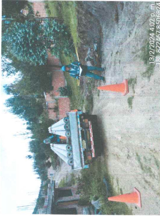
FOTO 21.- SUPERVISION EN ETAPA DE TRASLADO DE POSTES A PIE DE IZAJE PARA SER IZADOS POR LA CONTRATISTA EN LA APV ,CHECTACCACCA HUAYNA QOROO.
