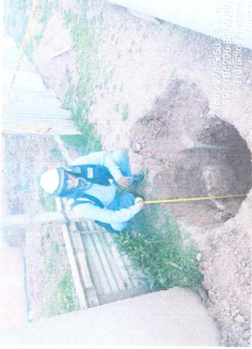
FOTO 3.- SUPERVISION, INSPECCIONANDO LOS HOYOS PARA EL IZAJE DE POSTES LA PROFUNDIDAD DE 1.30M Y DE ANCHO 0.65 M, EN LA APV CONJUNTO RESIDENCIAL PARAISO.
