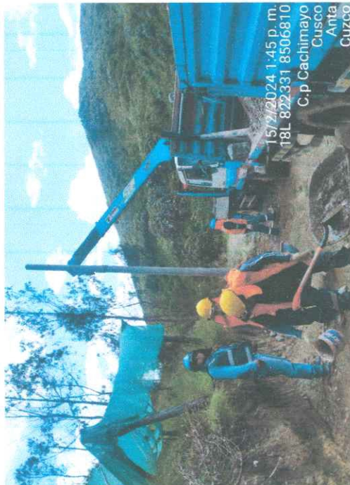
FOTO 25.- SUPERVISION INSPECCIONANDO EL TRASLADO DE LOS POSTES DE 8/300 Y 8/200. EN LA APV. LA QUEBRADA DE SAN ANTONIO, SE APRECIA LA PRESENCIA DE LA ING PREVENCIÓNISTA DE RIESGOS.
