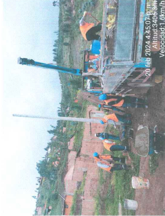
FOTO 34.- SUPERVISION INSPECCIONANDO LOS TRABAJOS DE IZAJE DE POSTE 8/300 EN LA APV.QUEBRADA DE SAN ANTONIO.
