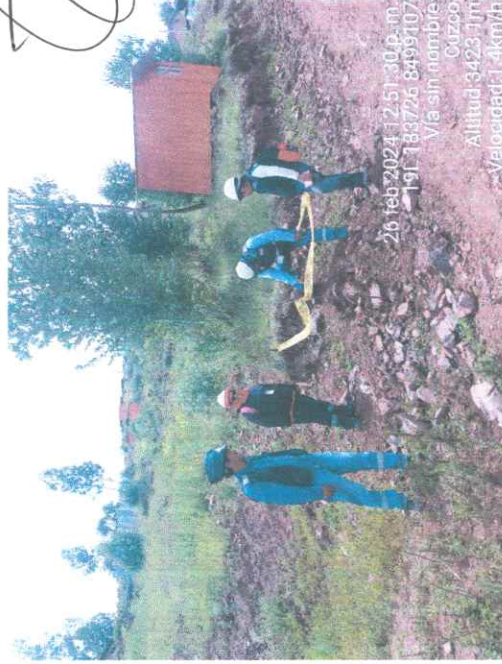
FOTO 46.- SUPERVISION INSPECCIONANDO LAS DIMENSIONES DEL HOYO APERTURADO PARA POSTE DE B.T., SE TIENE PRESENCIA DEL ING ASISTENTE DE RESIDENTE, ING PREVENCIÓNISTA DE RIESGOS Y ESPECIALISTA EN ARQUEOLOGÍA, EN LA APV QUEBRADA SAN ANTONIO.
