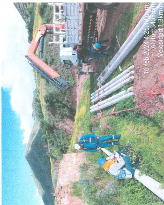
FOTO 27.- SUPERVISION INSPECCIONANDO LOS TRABAJOS DE TRASLADO E IZAJE DE POSTES DE 8/200 QUE REALIZO LA CONTRATISTA CONSORCIO EJECUTORES EN LA APV, QUEBRADA DE SAN ANTONIO.
