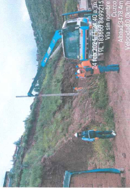
FOTO 44.- SUPERVISION, EN ETAPA DE IZAJE DE POSTE EN LA APV QUEBRADA DE SAN ANTONIO
