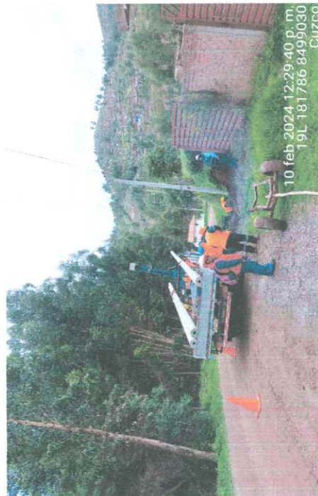
FOTO 18.- SUPERVISION INSPECCIONANDO LOS TRABAJOS DE IZAJE DE POSTE DE 8/200 JUNTAMENTE CON EL ING. DE SEGURIDAD EN LA APV. JARDINES DE LA PRADERA.
