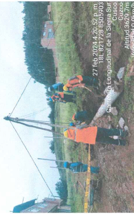
FOTO 48.- SUPERVISION EN ETAPA DE IZADO DE POSTE DE B.T. A MANIOBRA, EN LA APV MIRADOR DE YANAMAYO.
