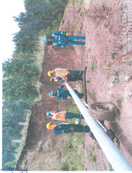
FOTO 35.- SUPERVISION, INSPECCIONANDO EL IZAJE DE POSTE. EN LA APV.QUEBRADA DE SAN ANTONIO.VER DETALLE DEL CORONADO DEL POSTE Y LA LIMPIEZA EN LA ZONA DE TRABAJO
