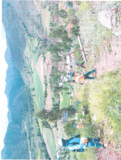
FOTO 49.- SUPERVISION EN ETAPA DE IZADO DE POSTE DE B.T. A MANIOBRA, EN LA APV QUEBRADA DE SAN ANTONIO.
