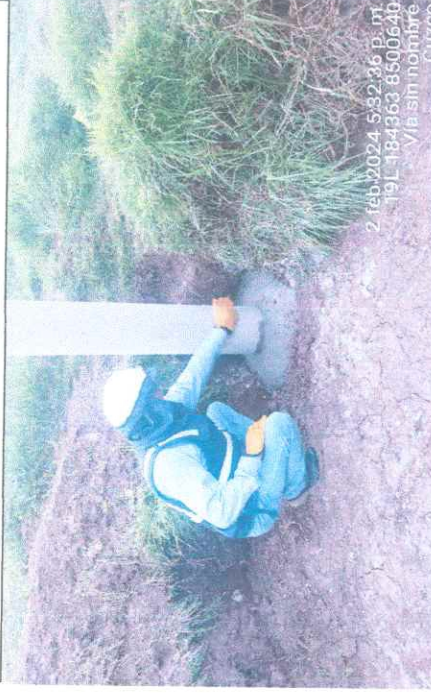
FOTO 3.- SUPERVISION, INSPECCIONANDO LOS HOYOS PARA EL IZAJE DE POSTES LA PROFUNDIDAD DE 1.30M Y DE ANCHO 0.65 M, EN LA APV CONJUNTO RESIDENCIAL PARAISO.
