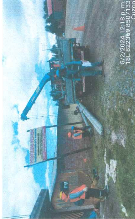
FOTO 8.- SUPERVISIÓN, INSPECCIONANDO LOS TRABAJOS DE TRALADO DE POSTES PARA EL IZAJE DE POSTES DE 8/300 EN LA APV CHECTACCACCA HUAYNA QORQO.
