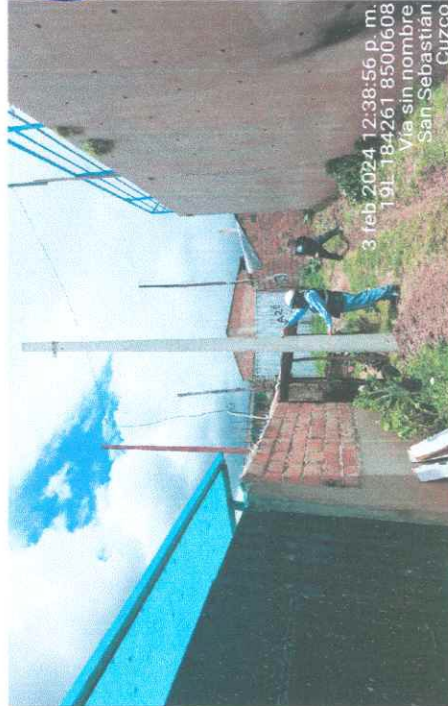
FOTO 6.- SUPERVISIÓN VERIFICANDO EL EMPOTRAMIENTO DE POSTE DE 8/300 DE PROFUNDIDAD 1.30 M. VER DETALLE DEL ACABADO AL EMPOTRAMIENTO TIENE 1.70 M EN LA APV CONJUNTO RESIDENCIAL PARAISO.
