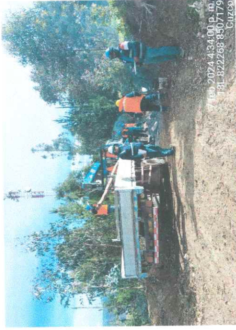
FOTO 11.- SUPERVISION, INSPECCIONANDO LOS TRABAJOS DE IZAJE DE POSTE DE 8/300 EN LA APV. CHEETACCACCA HUAYNA QORQOR.
