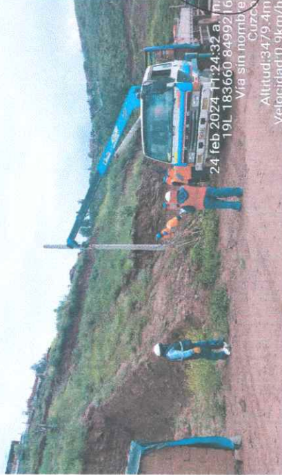
FOTO 42.- SUPERVISION, INSPECCIONANDO LOS TRABAJOS DE IZAJE DE POSTE 8/300 JUNTAMENTE CON EL ING. PREVENCIÓNISTA DE RIESGOS EN LA APV QUEBRADA DE SAN ANTONIO.
