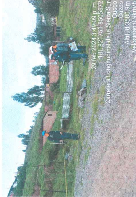
FOTO 56.- SUPERVISIÓN VERIFICANDO EL REPLANTEO DE OBRA, EN LA APV MIRADOR DE YANAMAYO. VER DETALLE DE PARTICIPACIÓN DEL RESIDENTE, MAESTRO DE OBRA.
